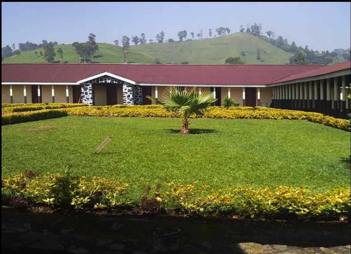
Une partie des bâtiments a été restaurée
