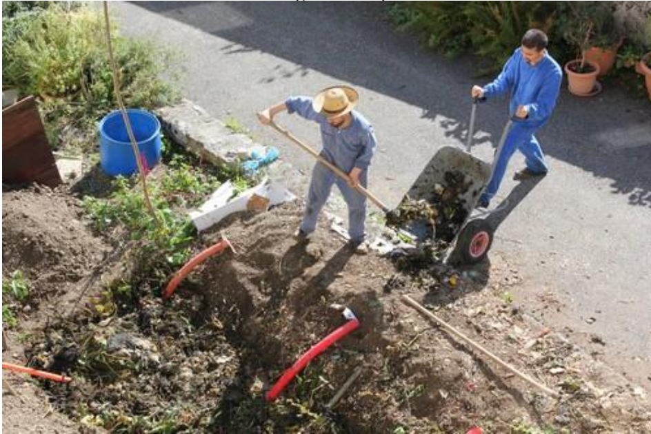
Arrosage Par la suite les tuyaux le permettront par le bas
